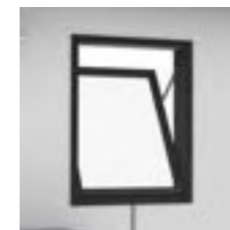
Evacuatori naturali di fumo e calore, aperture per l'afflusso di aria Natural smoke and heat evacuators, openings for the inflow of air
